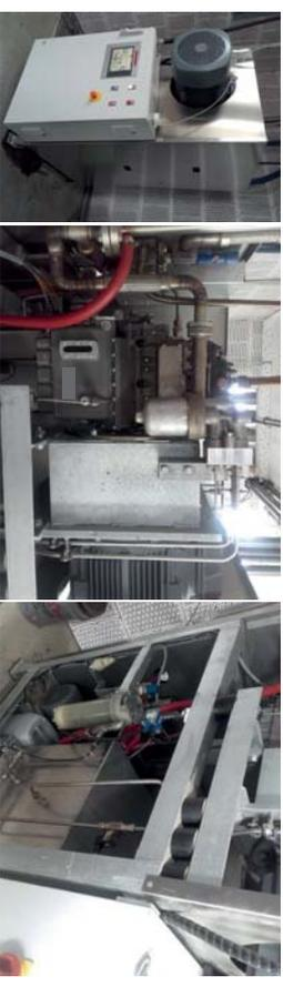
li: Stromerzeugeneinheit von vorne /mi: Dampfmotor und Generator /re: Tank und Pumpensystem
