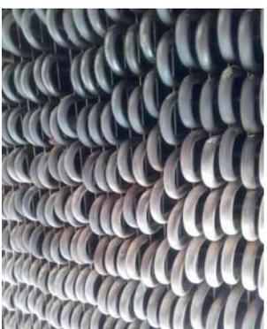
Das heiße Abgas wirkt mittels Temperatur (z.B. 500°C) und Volumenstrom außen an dieser großen Tauscheroberfläche auf das destillierte Wasser.
