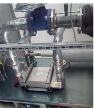
Nach Abgabe der Wärme gelangt das destillierte Wasser wieder zurück in den Tank der **AWN-Stromerzeuger und Wärmetauscher-Einheit**.
