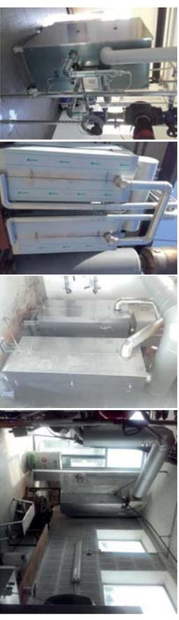
li: Stromerzeugeneinheit von hinten mit Übergabe Wärme über Plattenwärmetauscher an Heiznetz
