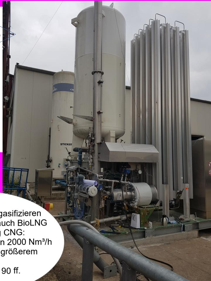
Pilotanlage zum Regasifizieren
