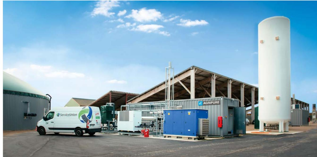
Das vorbehandelte und komprimierte Biogas wird mit einem Membrantrennverfahren aufbereitet, wobei ein methanreiches Produktgas und ein CO<sub>2</sub>-reiches Nebengas entstehen. Die innovative 3-stufige Membrankonfiguration kann eine Biomethan-Reinheit von > 99 % erzeugen. Die Membrantrennstufe und das Steuersystem sind in einem einzelnen, maßgeschneiderten Container untergebracht
