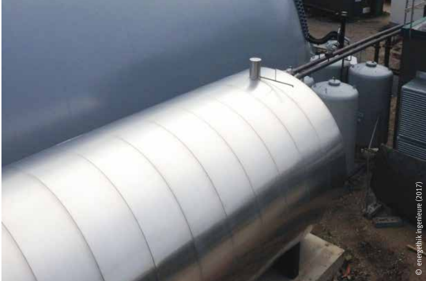
Abb. 29: BHKW, Gasspeicher, Wärmespeicher in Bünthe: Der Satellitenstandort auf dem Gelände einer Kläranlage wurde zum Kern der Flexibilisierung der Biogasanlage von 600 auf 2.600 kW.
