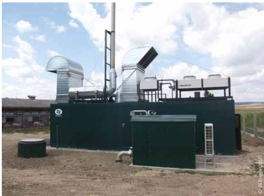
Abb. 17: BHKW bis 2.000 kW können kostengünstig im Container installiert werden
