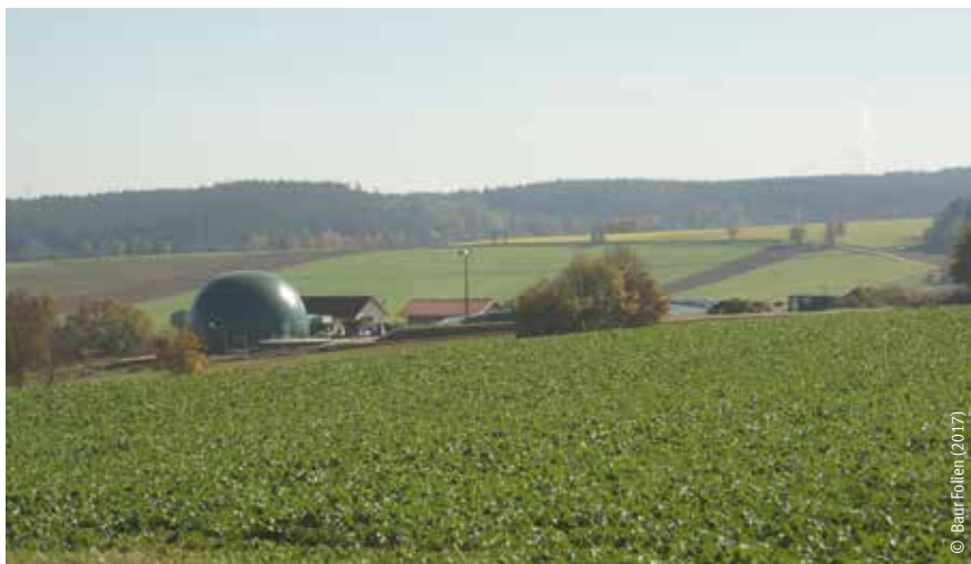
Abb. 19: Zusätzliche Reingasspeicher können auch ebenerdig errichtet werden
