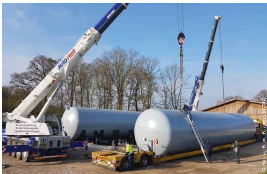
Abb. 20: Liegende Wärmespeicher: Moderne Stahlspeicher kommen vorgefertigt mit Spezialtransportern. An der Biogasanlage Ströhen werden 2 \times 300 \text{ m}^3 Wärmespeicher auf vorinstallierten Fundamenten installiert.
