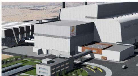
Dubai, weltgrösste EfW Anlage, BOO, 1'890 kt/a, 193 MW<sub>el</sub> (im Bau)
