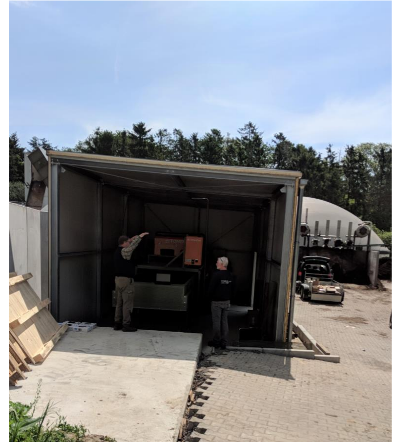
Biogasanlage Kraft GmbH & Co. KG
